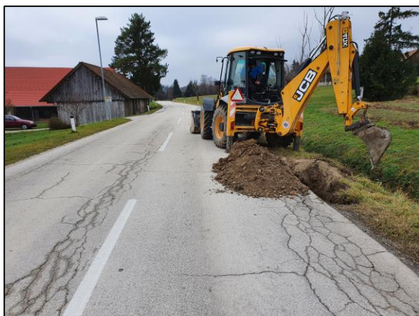
Slika 10: Sondažni razkop SJ2, dec. 2020
